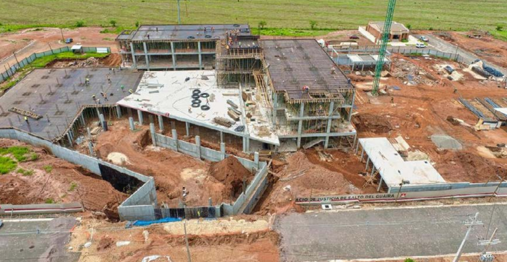
Avance de obra de la futura sede judicial de Salto del Guairá.
