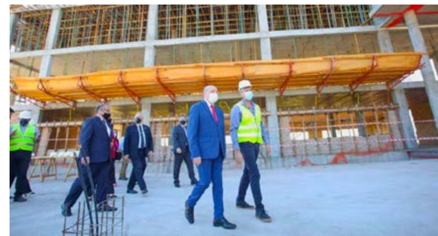
Avance de obras del futuro Palacio de Justicia de Salto del Guairá.
