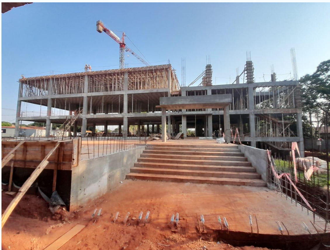
AVANCE DE OBRA-CAPIATÁ
